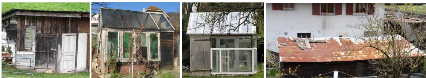
Amas de matériaux en tous genres et 'ruines' sont à démolir
